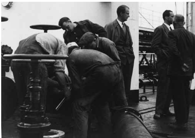
Хальдор Топсе на строительстве одной из установок компании в Швеции, 1950 г.
